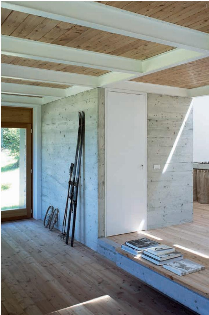
**1\_Puristisch:** Eingang und Küche trennt ein Kubus aus Sichtbeton – darin befindet sich das Badezimmer. Über der offenen Stahlkonstruktion ist die Schlafebene.
